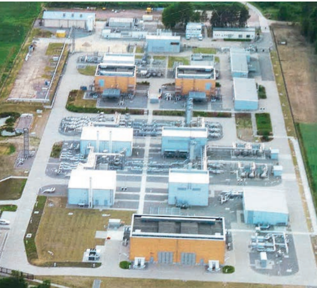
Der Erdgasspeicher Peckensen der Firma Storengy aus der Vogelperspektive. Als Speicherbetreiber ist das Unternehmen die Nummer 1 in Europa und die Nummer 4 weltweit.
