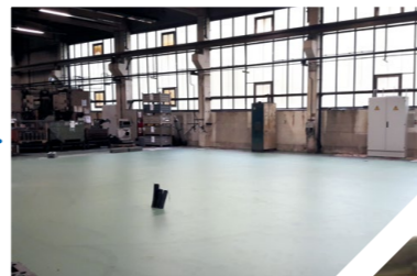
Anschließend wurde der Boden saniert.
